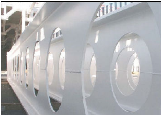
Figur 1: Hålbalkar tillverkade av valsade profiler.
