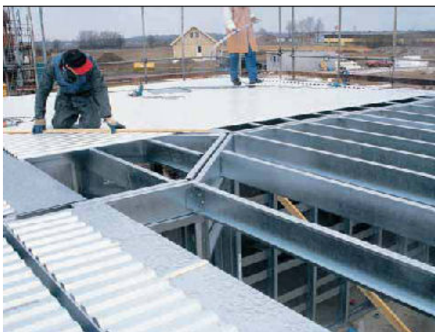
Figur 2: exempel på tunnplåtsbjälklag
