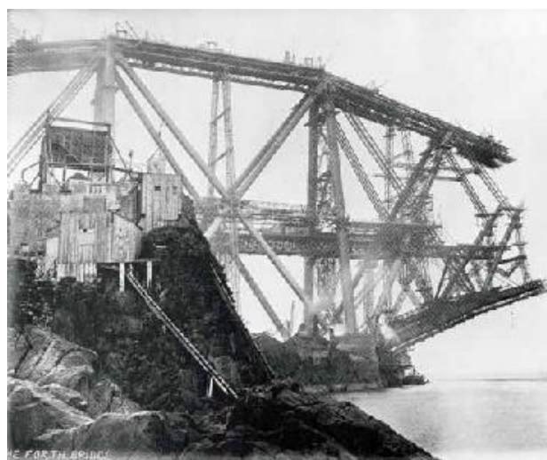
Bron under byggande vid ön Inchgarvie.
