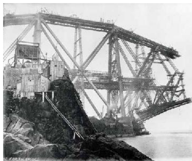
Bron under byggande vid ön Inchgarvie.
