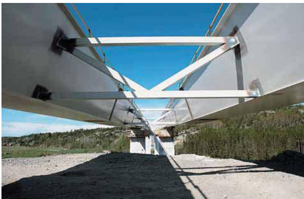
Tvillinglådorna sammanbundna med fackverk – att analysera sammanlagda effekterna av vridning för detta tvärsnitt är en arbetsam uppgift – utförd av Ramböll.
